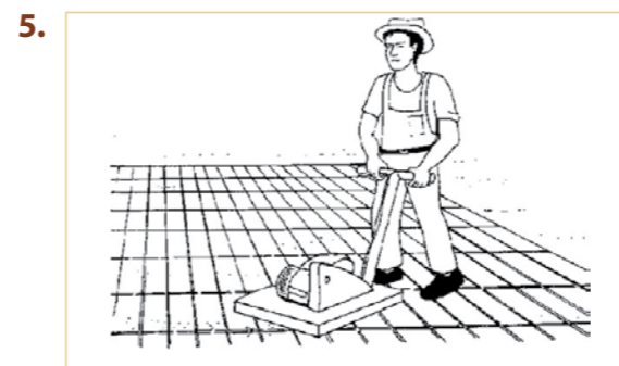
5. Fontos! Csak száraz állapotban vibráljunk. Azután az egész leburkolt felületet még egyszer terítsük be homokkal.
